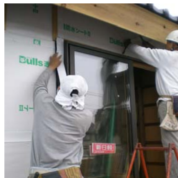
■サッシ開口部 サッシはすべて断熱サッシ+ペアガラスに替える。外部の防水はサッシ取り付け部に特に注意してテープ処理する。(中)下屋部の立ち上がりも20cm以上の防水処置を行う。
