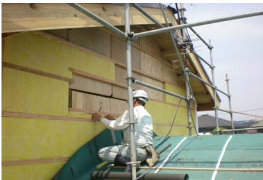
■付加断熱 合板の外にHGW32K品45mmを付加断熱する。
