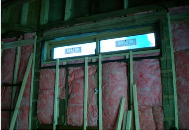
■壁内部の不陸 既存壁の不陸対応は新たな下地造作 防湿さえすれば断熱材は如何ようでも可能。一見頼りなさ
