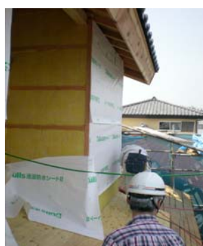
■付加断熱 合板の外にHGW32K品45mmを付加断熱する。
