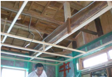
■防湿気密 天井ポリエチレンシート0.2mmを天井面に施工し、この上にグラスウールを吹き込む。このシートが天井面の防湿と気密層になる。(左)壁も同シートで防湿気密層をつくるが部位によっては外合板+パッ
