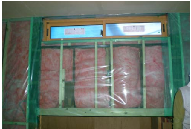
■壁内部の不陸 既存壁の不陸対応は新たな下地造作 防湿さえすれば断熱材は如何ようでも可能。一見頼りなさ
