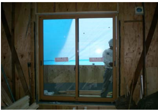
■サッシ開口部 サッシはすべて断熱サッシ+ペアガラスに替える。外部の防水はサッシ取り付け部に特に注意してテープ処理する。(中)下屋部の立ち上がりも20cm以上の防水処置を行う。
