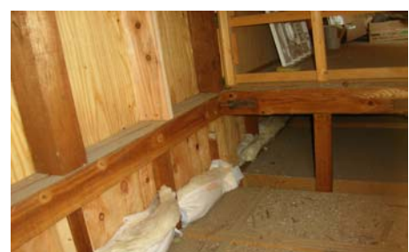
■気流止め サ壁内の気流を止めるために部品化した圧縮グラスウールを用いる。柔軟な対応は豊富な経験があれ
