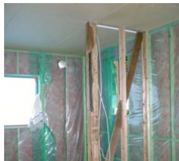
■防湿気密 天井ポリエチレンシート0.2mmを天井面に施工し、この上にグラスウールを吹き込む。このシートが天井面の防湿と気密層になる。(左)壁も同シートで防湿気密層をつくるが部位によっては外合板+パッ
