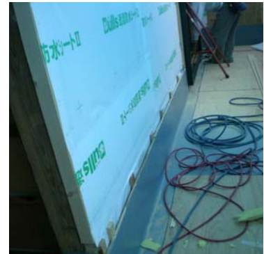
■サッシ開口部 サッシはすべて断熱サッシ+ペアガラスに替える。外部の防水はサッシ取り付け部に特に注意してテープ処理する。(中)下屋部の立ち上がりも20cm以上の防水処置を行う。
